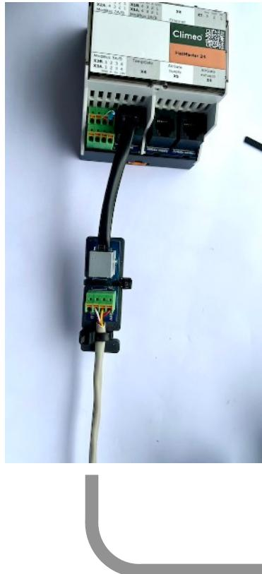
Die AirGates werden über einen RJ12-Klemmen-Adapter angeschlossen. Das Kabel sollte ein 2x2-adrig verdrilltes 0.8 mm<sup>2</sup> ModBuskabel sein.
